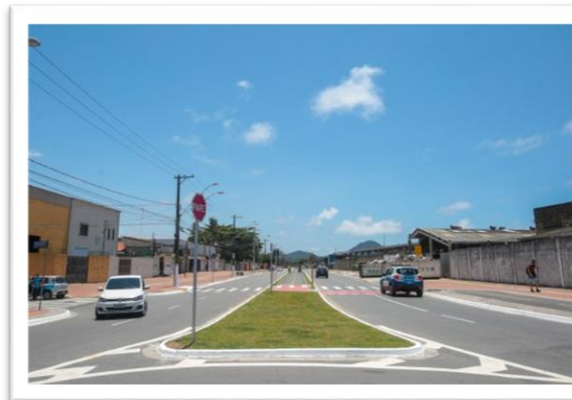
Reurbanização da Avenida do Trabalhador
