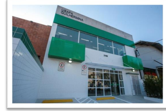
USAFÁ Guillermina, no bairro Guillermina
