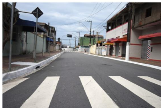
Obras do Sistema Viário do Cidadão (Melvi, Samambaia, Esmeralda e Ribeirópolis)
