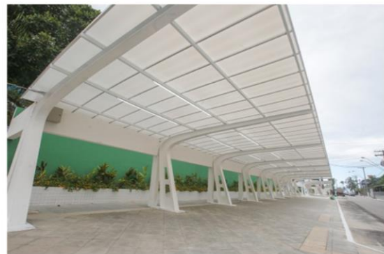
Remodelação da Avenida dos Sindicatos
